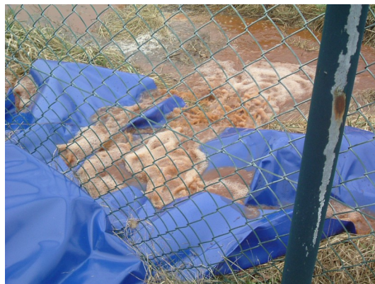
Rohrnetzspülung: Spülwasserauslass über Spültuch
