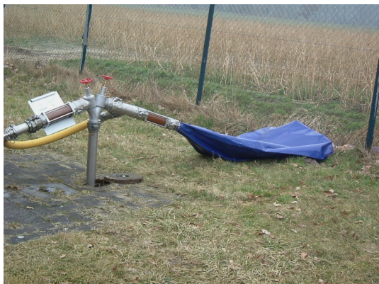
Rohrnetzspülung: Spülwasserauslass über Spültuch
