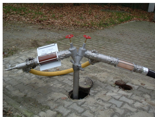
Rohrnetzspülung: Hydrantenstandrohr mit Schaugläsern zur Beobachtung des Spülverlaufes
