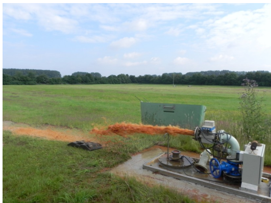
Spülung einer Rohwasserleitung Ausgespült am Brunnenkopf
