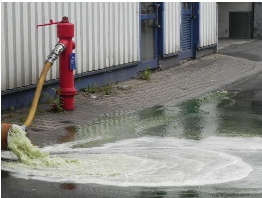
Spülung einer Kaltwasserleitung (Kühlwasser in der Industrie)
