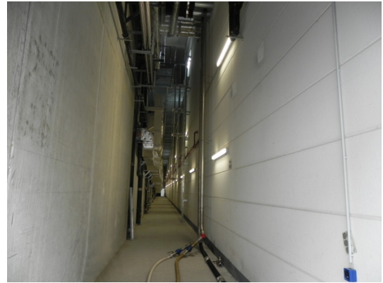
Spülung einer Kaltwasserleitung (Kühlwasser in der Industrie)
