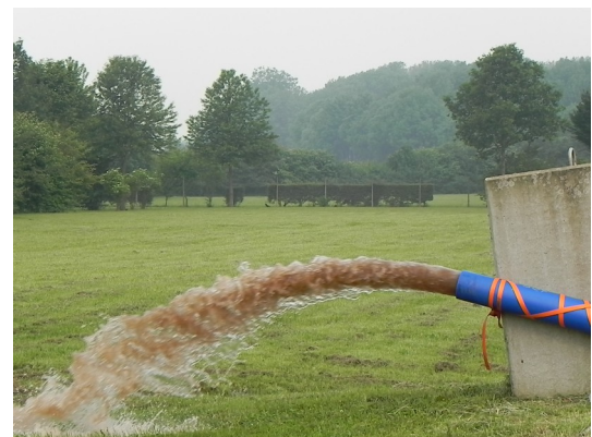
Spülung einer Rohwasserleitung Ausgespült am Brunnenkopf
