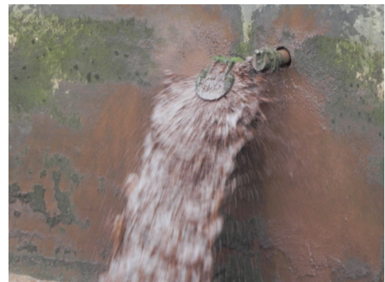
Spülung einer Rohwasserleitung DN600 in ein Schlammabsetzbecken
